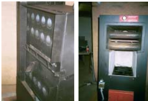
Detalj på sekundärluftspjäll (t v) och på rosterkonstruktion och konvektionsdel (t h). Notera att baffelplåten ligger på distans från den undre raden konvektorrör.
