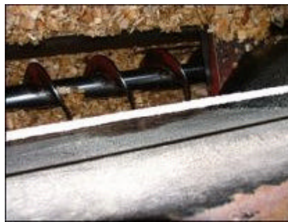
Här matas flisen ner till den första delen av den långa doserskruven som sedan transporterar bränslet till pannan.
