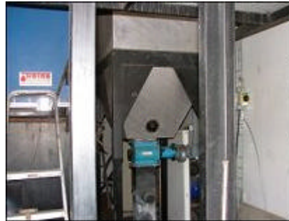
Man har också konstruerat så att flygaskan i rökgaserna samlas upp i en silo som i sin tur matas till det övriga asksystemet.
