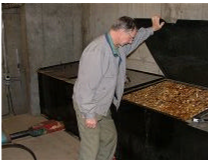
Hindefelt visar rummet där dom stora hydragstyrda rakorna drar fram flisen till skruven.
